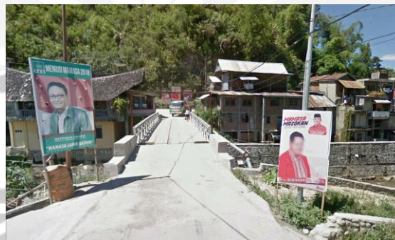
Gambar 1.1. Kondisi Jembatan Tedong Tedong sebelum Banjir
