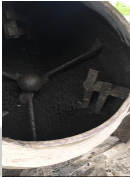
Proses Pengadukan Beton
