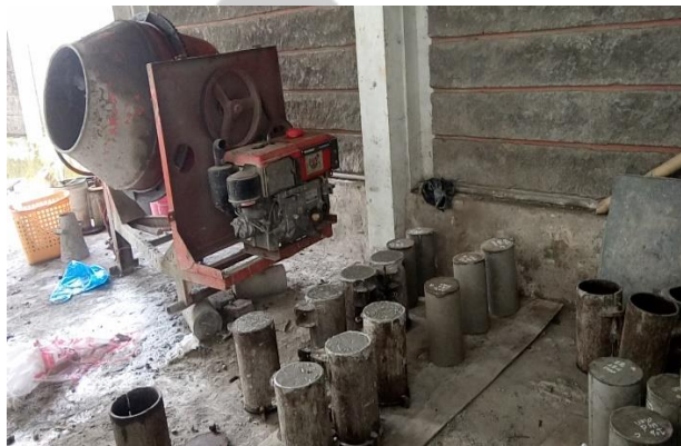
Campuran beton setelah dicetak
