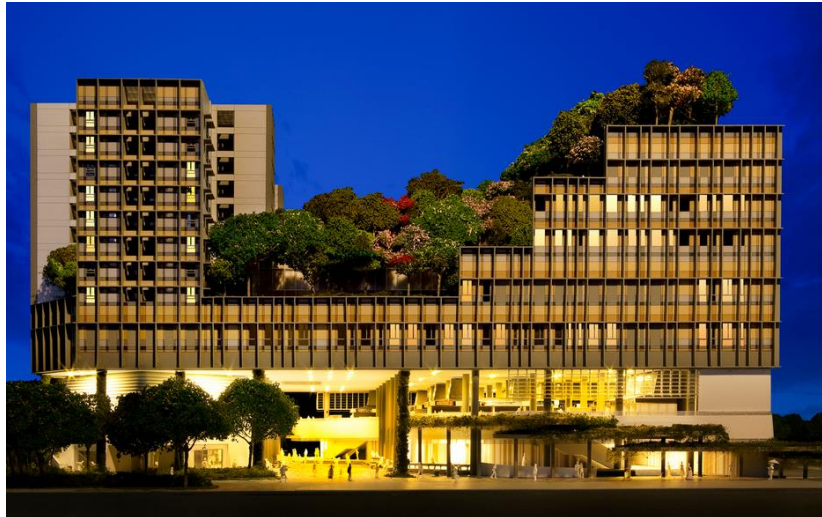
Gambar 2.63 Tampak Depan Kampung Admiralty Sumber: ( https://www.archdaily.com , diunduh 2017)
