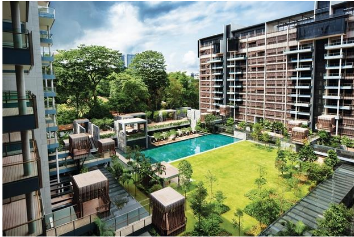
Gambar 2.32 Taman dan Kolam Renang pada bagian tengah Kawasan Apartemen
