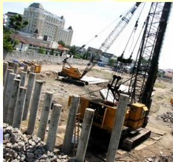
Gambar 6.26 Konstruksi Pondasi Tiang Pancang Sumber : images.google.com , diakses pada 07 Desember 2017
