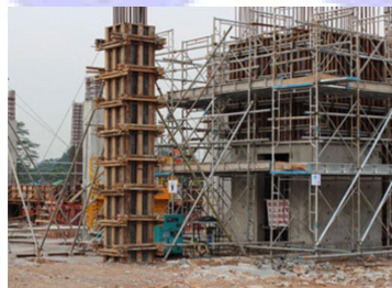
Gambar 6.27 Konstruksi Struktur Beton Sumber : images.google.com , diakses pada 07 Desember 2017
