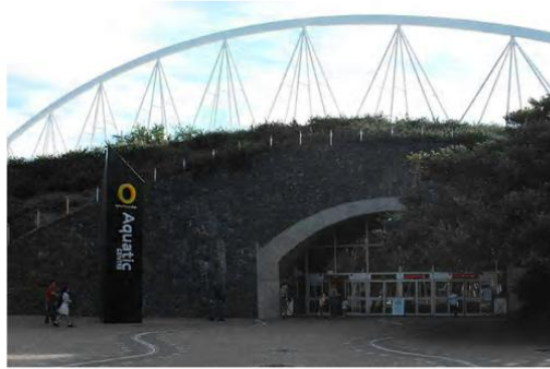
Gambar 2.38 Entrance dari Sydney International Aquatic Center Sumber : http://en.wikipedia.org
