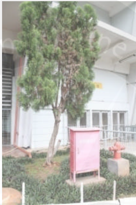
Gambar 2.33. Foto Kelengkapan Pemadam Kebakaran Gelora Bung Karno. (Sumber: wikipedia.org/gelora_bung_karno/akses_27-08-2009 )
