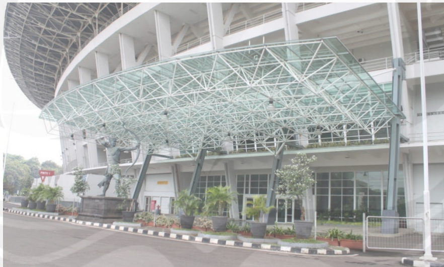
Gambar 2.30. Foto Pintu VIP Gelora Bung Karno. (Sumber: wikipedia.org/gelora_bung_karno/akses_27-08-2009 )
