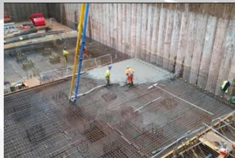
**Gambar 2.10** Konstruksi *waste bunker* dengan pondasi raft
