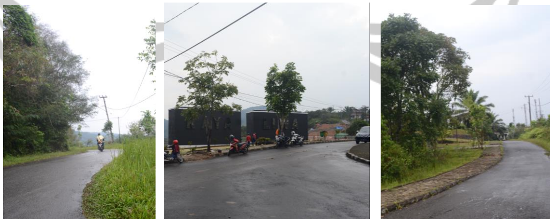
Gambar 3.3 4 Kondisi eksisting jalan
