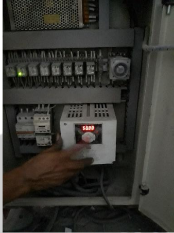
Kecepatan yang telah diatur berdasarkan ketebalan plat baja ringan
