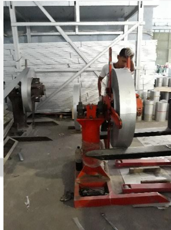
Pemasangan gulungan plat baja ringan ( coil ) ke uncoiler
