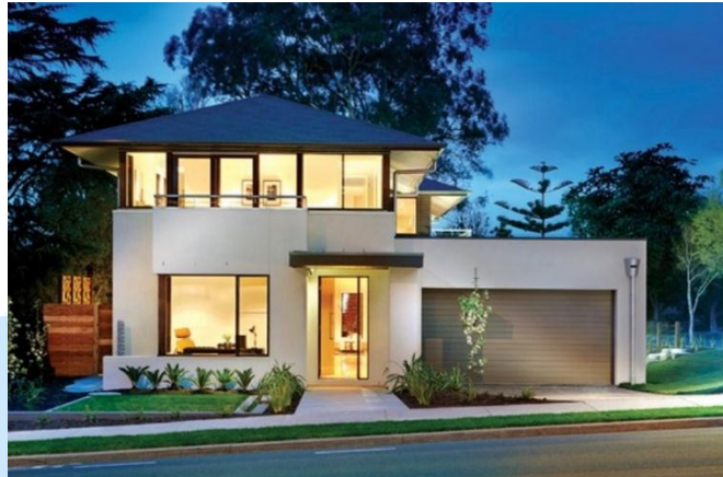
Gambar 5.28 Atap limasan pada bangunan
