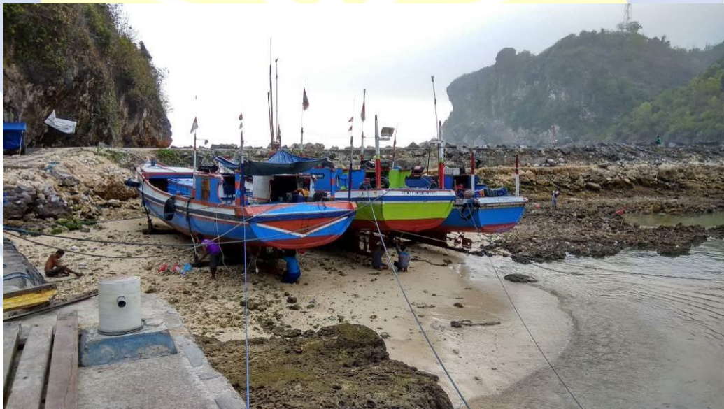
Gambar 61. Tempat Perbaikan Kapal Memanfaatkan Pemecah Ombak
