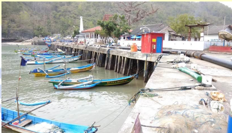
Gambar 86. Struktur Deck on Pile di Pelabuhan Perikanan Sadeng
