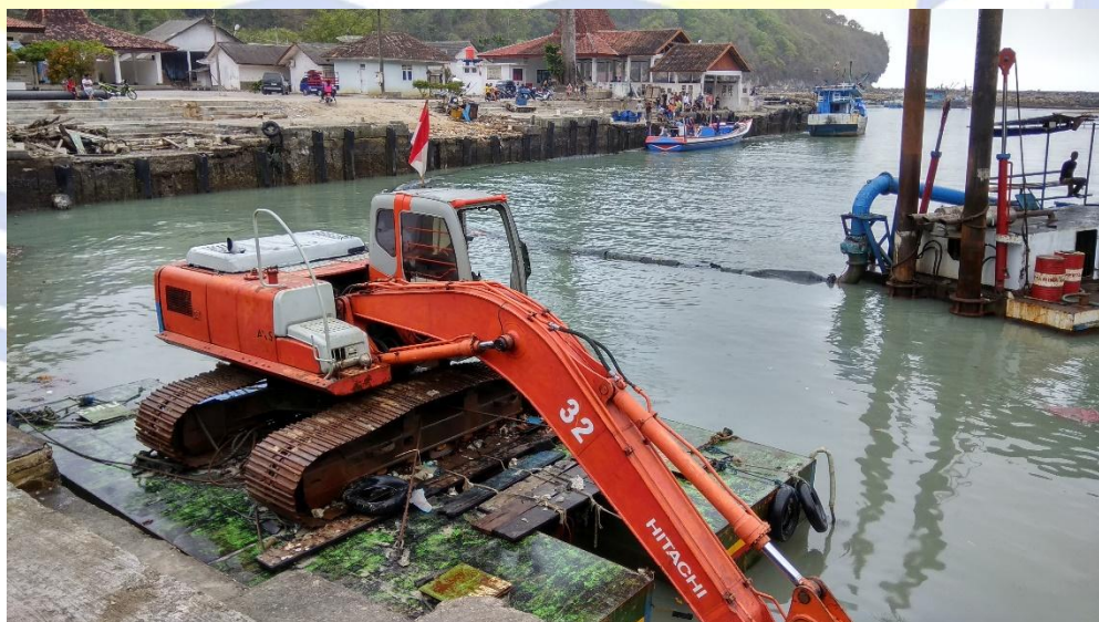
Gambar 54. Renovasi Ringan Pada Pelabuhan Perikanan Pantai Sadeng
