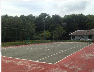
Gambar 2.12 Lapangan Tenis Sumber : dokumentasi penulis, 2017
