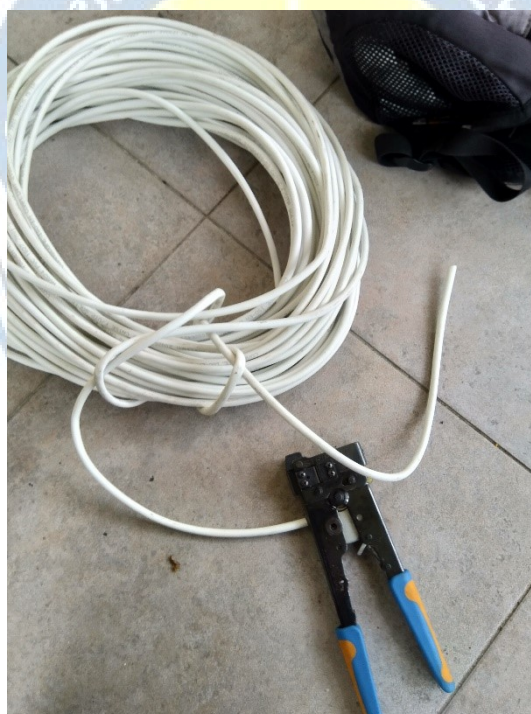
Gambar 2.3.18 Crimping kabel untuk perpindahan BTS
