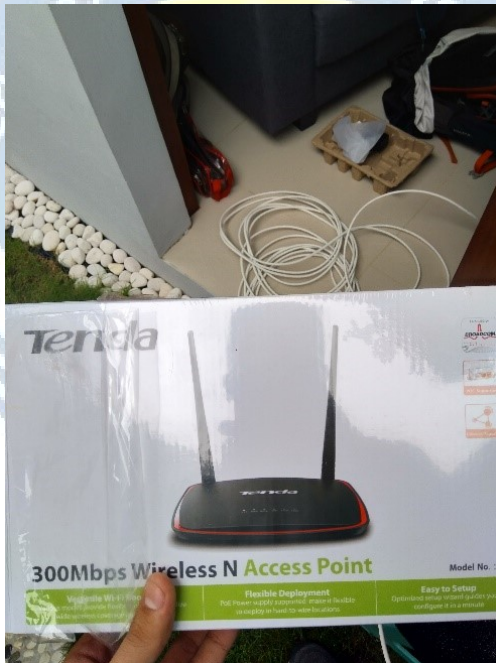
Gambar 2.3.8 Proses instalasi di daerah Gamping dengan menggunakan access point
