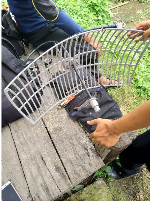
Gambar 2.3.1 Pemasangan antenna baru untuk BTS di daerah Jalan Parangtritis
