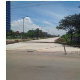
Jalan di sisi utara site
