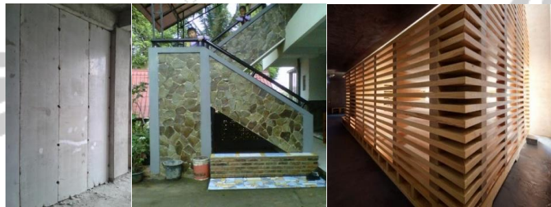
Gambar 6.8 : Dinding Beton Ringan, Dinding Batu Alam dan Dinding Kayu
