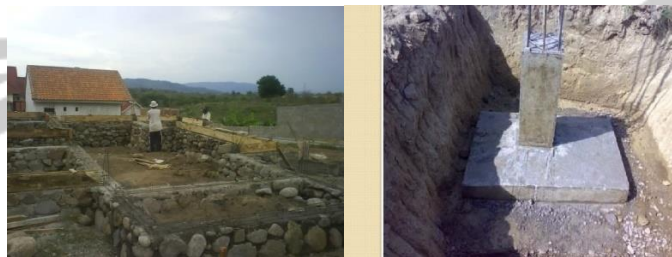
Gambar 6.6 : Pondasi Batu Kali dan Pondasi Foot Plate
