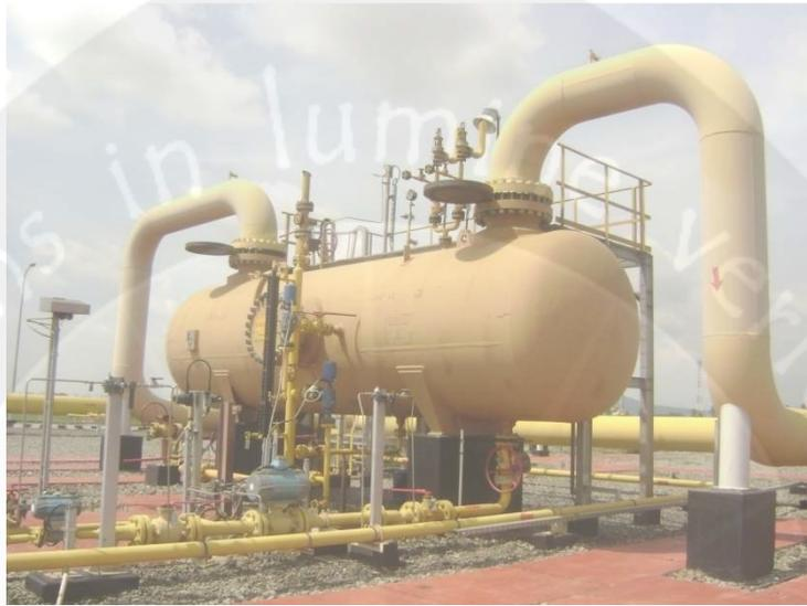
Gambar 1.1 Tampak Samping *Slug Catcher* Eksisting di Stasiun Bojonegara
