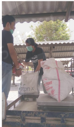
Proses penimbangan material untuk beton
