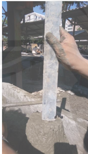
Pengujian Slump Beton Fas 0,3
