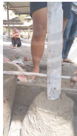
Pengujian Slump Beton Fas 0,4
