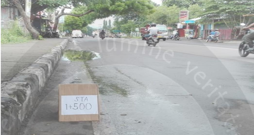
Gambar Marka Jalan yang Mulai terhapus dan Genangan Air Pada Jalan
