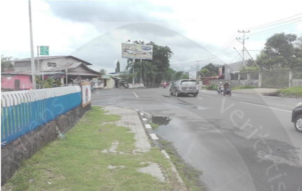
Gambar Genangan Air di Permukaan Jalan dan Marka Jalan yang Tertutup Pasir
