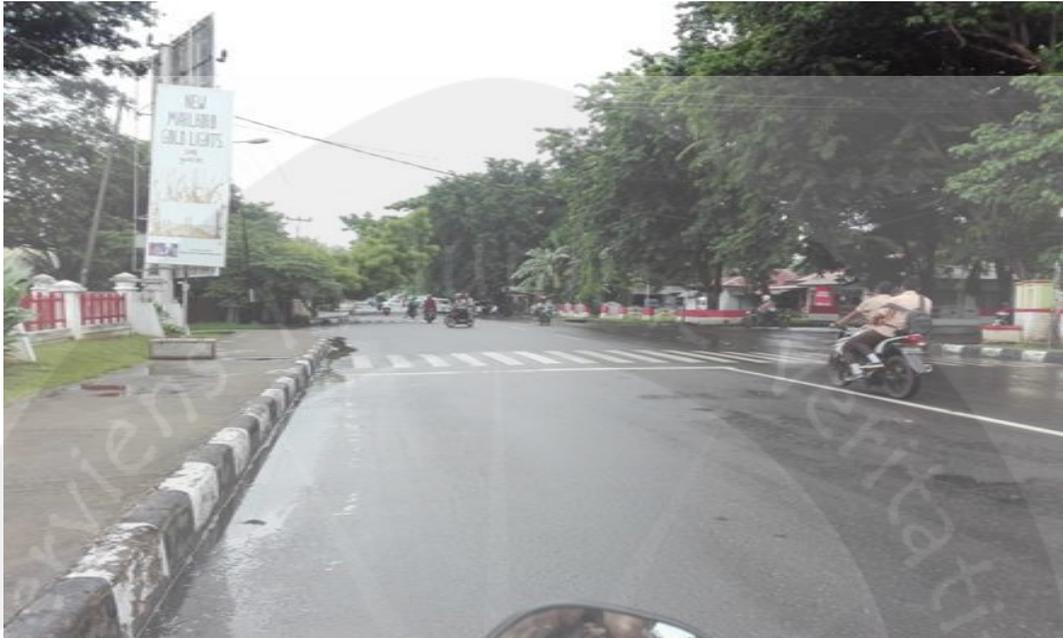
Gambar Persimpangan yang Belum Dilengkapi APILL dan Marka Jalan yang Mulai Terhapus
