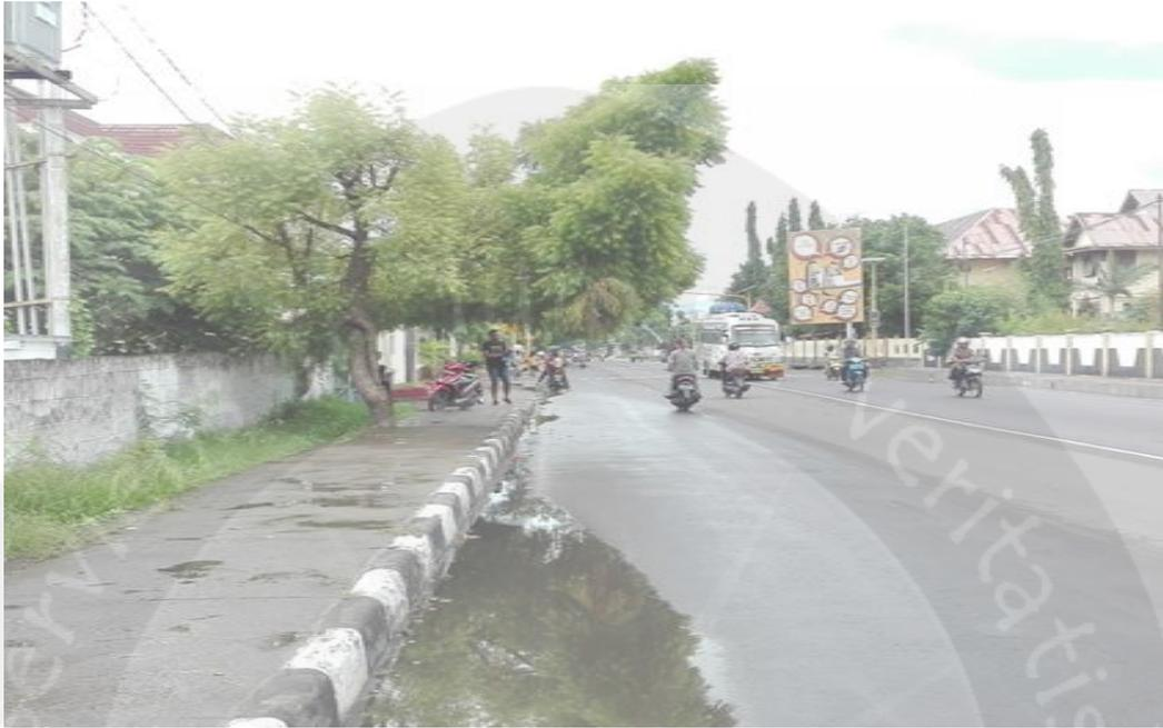
Gambar Marka Jalan yang Mulai Terhapus dan Genangan Air di Permukaan Jalan
