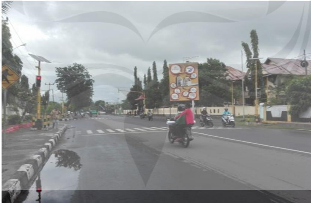
Gambar Sisi Kanan APILL yang Tidak Berfungsi dan Genangan Air di Permukaan Jalan Serta Marka Jalan yang Mulai Terhapus
