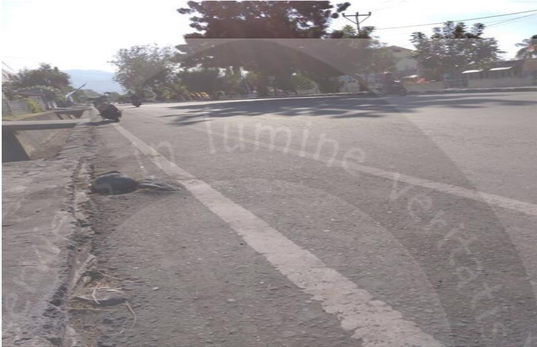
Gambar Kondisi Jalan yang Berlubang yang Ditutupi Dengan Batu
