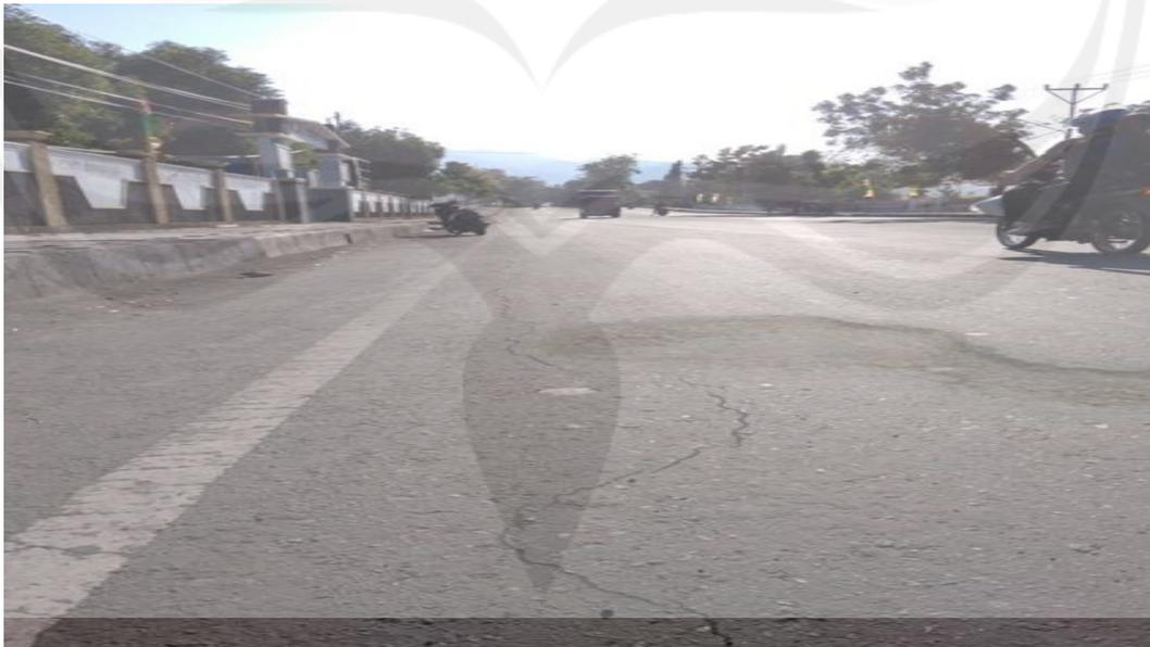
Gambar Kondisi Jalan Berlubang dan Mengalami Keretakan
