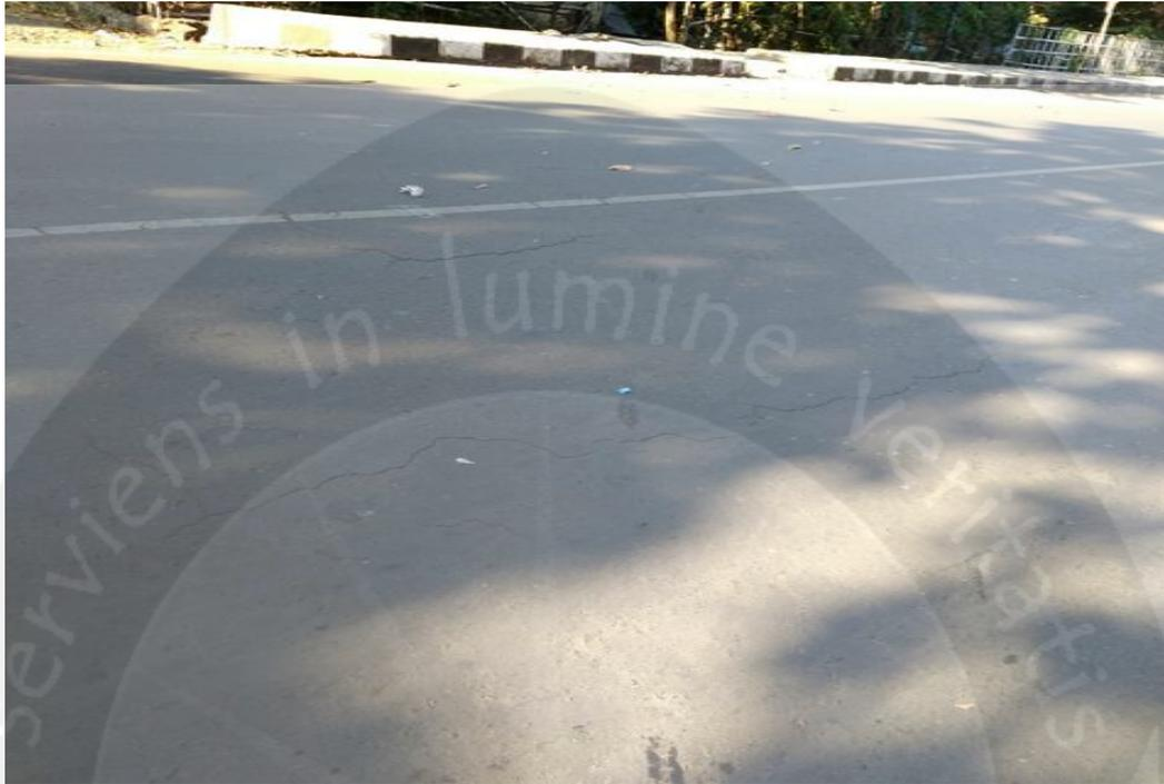
Gambar Kondisi Jalan yang Mengalami Keretakan
