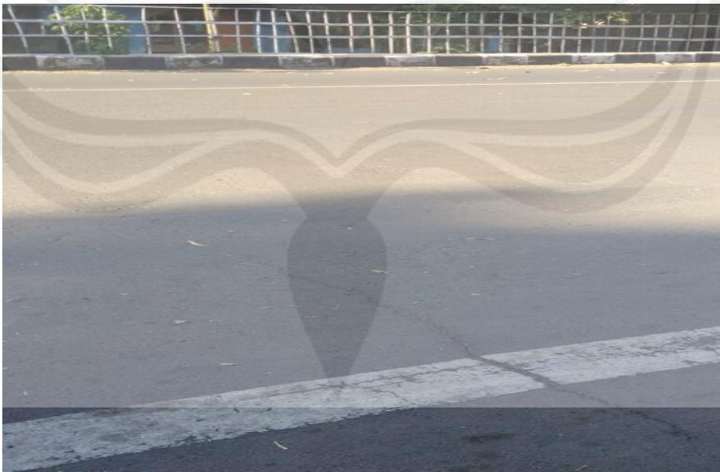
Gambar Kondisi Jalan yang Mengalami Keretakan
