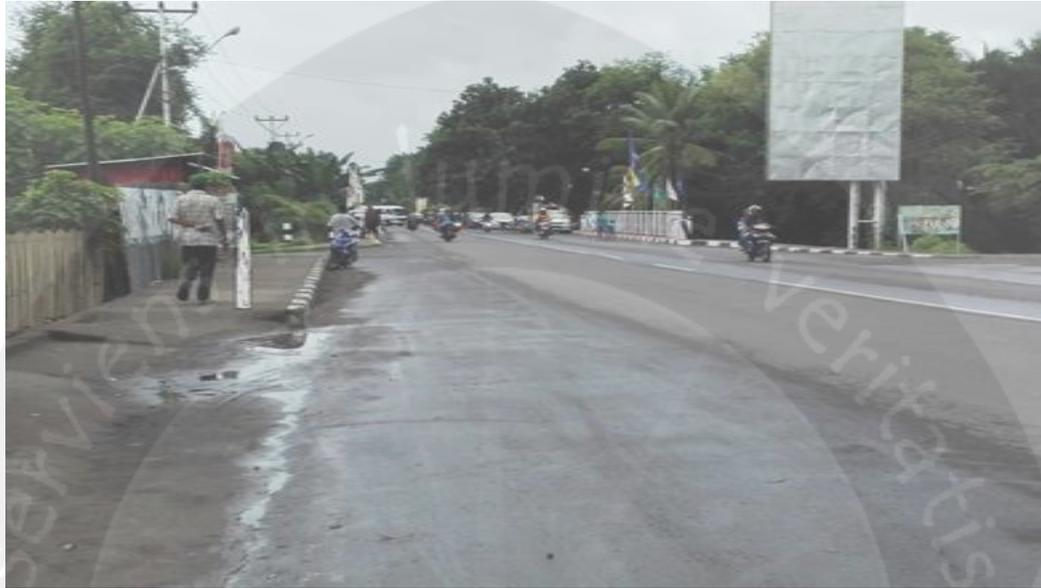
Gambar Marka Jalan yang Mulai Terhapus dan Rambu Jembatan yang Belum Ada
