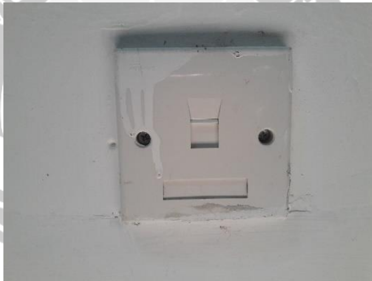
Gambar 2.14 Port di Dinding (sebelum pelabelan)
