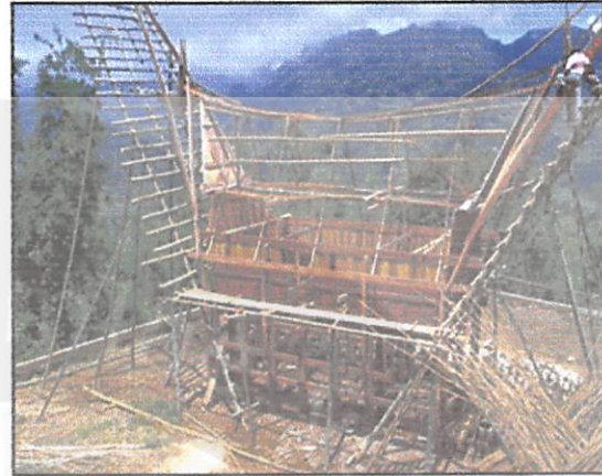
Pengerjaan konstruksi rumah Toraya
