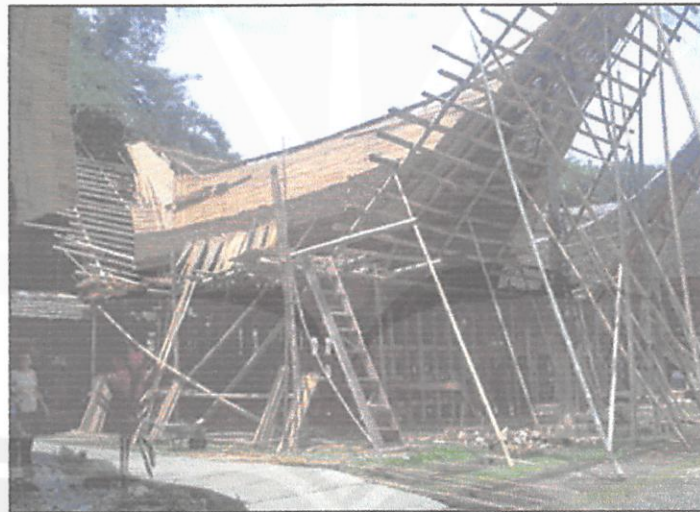
Proses finishing pengerjaan atap
