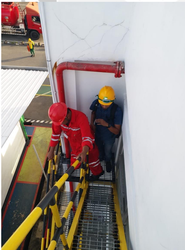
Gambar 5. Penarikan Kabel LAN
