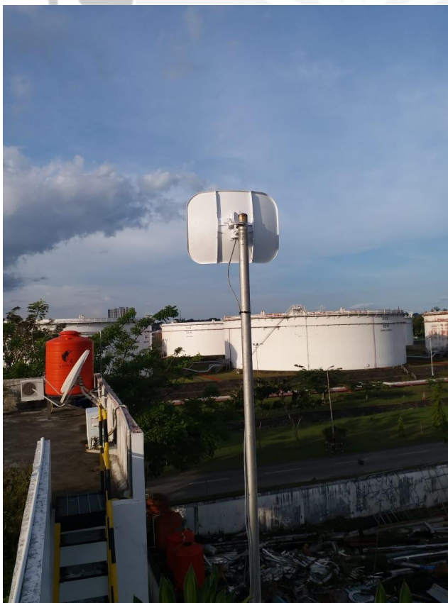
Gambar 21. Instalasi Lite Beam
