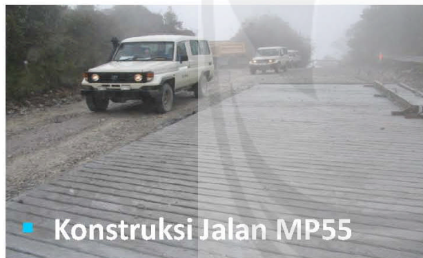
■ Konstruksi Jalan MP55
