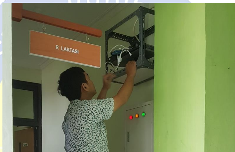
Gambar 2.17 Pengecekan Kabel LAN, POE, dan Switch
