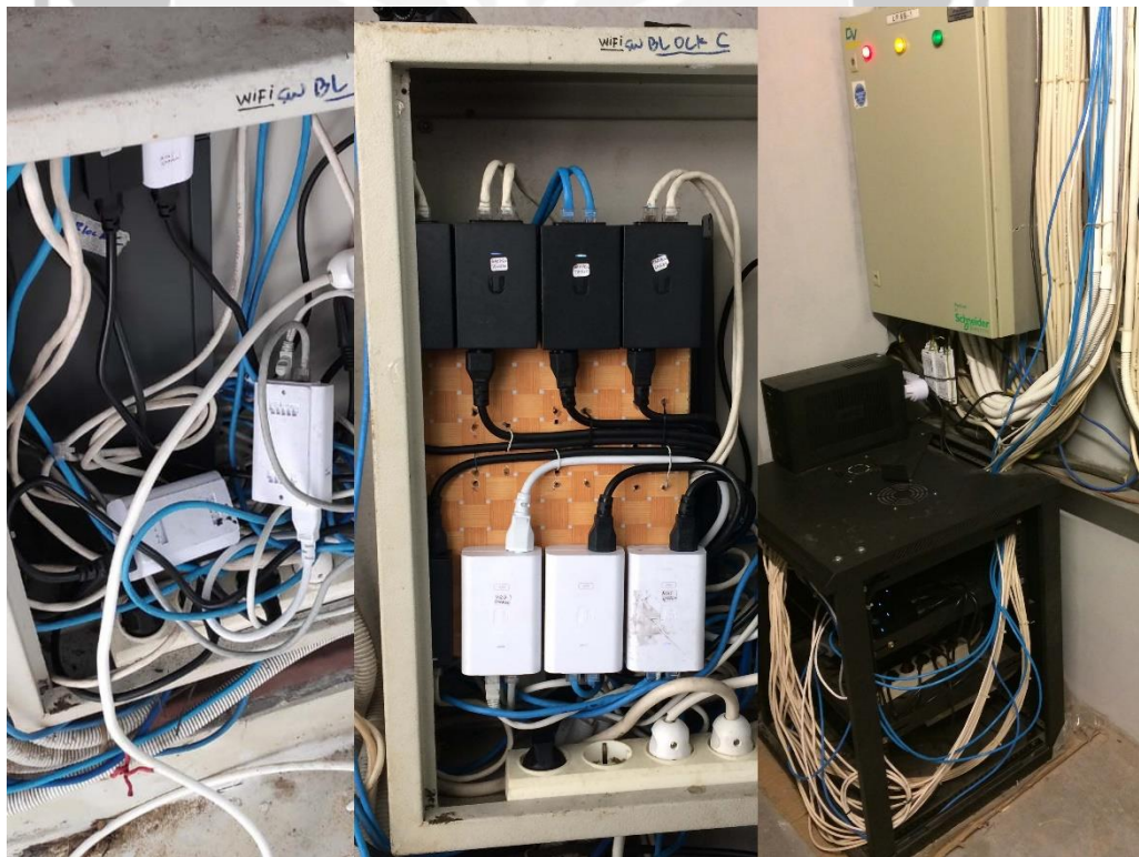
Gambar 2.12 Memeriksa dan Merapihkan Kabel-Kabel
