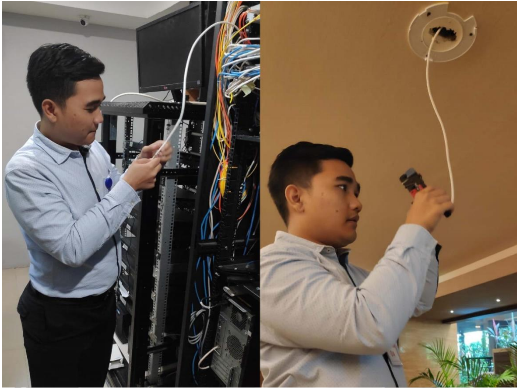
Gambar 2.7 Proses Creamping Kabel pada Masing-Masing Ujung Kabel
