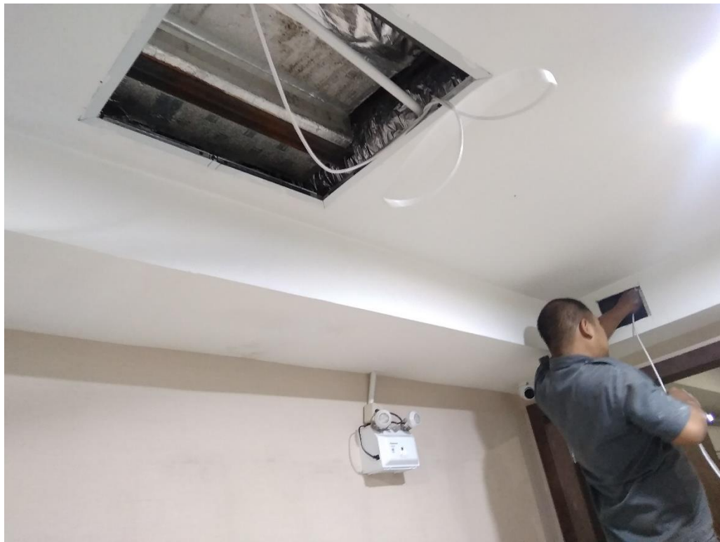
Gambar 2.5 Proses Penarikan Kabel LAN
