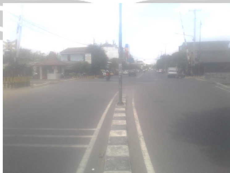
Gambar 1.2 Pintu Perlintasan ditinjau dari Arah Selatan
