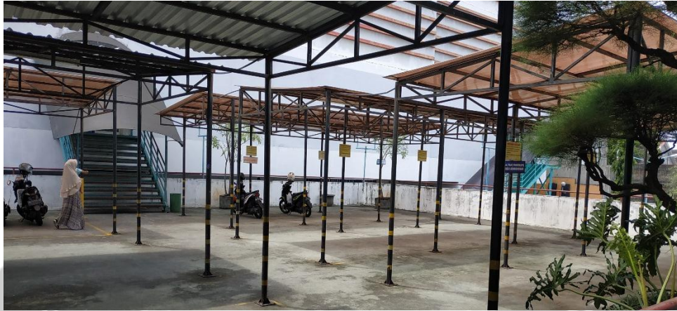
Gambar L.3. Areal Parkir Sepeda Motor Utility Atas
