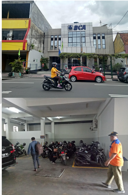
Gambar L6.3 Lokasi Parkir Mobil Pada Bank BCA Ahmad Dahlan
