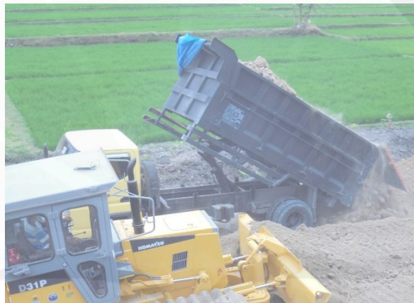
Gambar 1.3 Proses Pengurukan Tanah Km. 451+800 (sumber: Data Lapangan)
