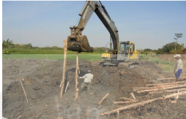
Gambar 1.2 Pemasangan Dolken Km. 451+800 (sumber: Data Lapangan)
