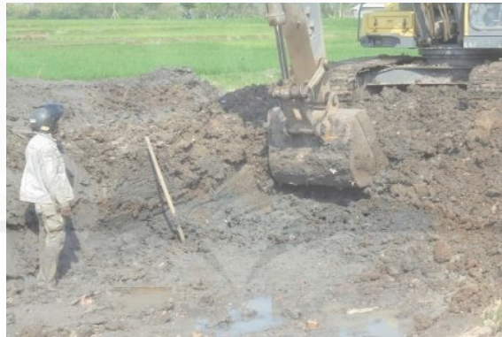
Gambar 1.1 Galian Tanah Untuk Pemasangan Dolken Km 451+800 (sumber: Data Lapangan)
