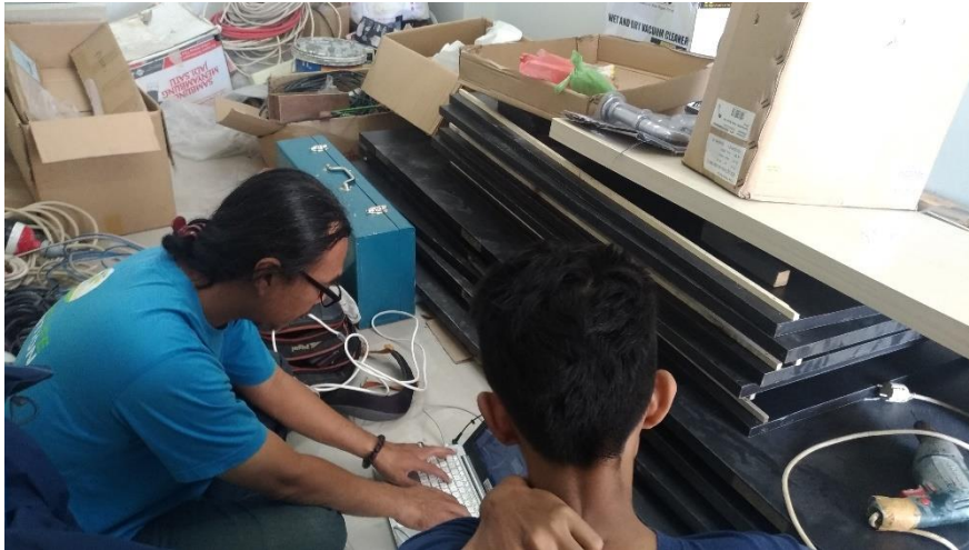
2.3.15 Pemasangan Ap dan setingan AP + Router di zona a yaitu Gedung baru pada Hotel Cipta Pakem
