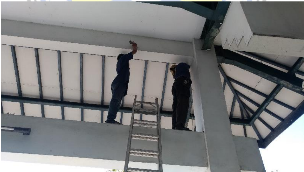
2.3.2 Pengawasan Pemasangan Kabel jaringan untuk kegiatan LKS di JEC
