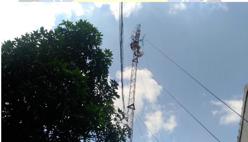
2.3.6 Membantu pegawai citra net memasang antenna di tower terabit
