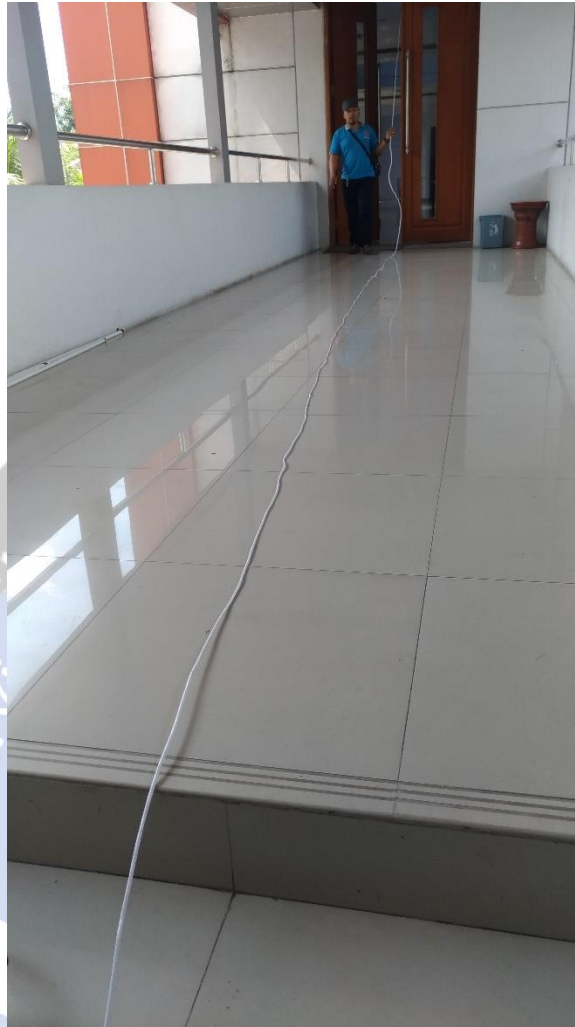
2.3.14 Melanjutkan pekerjaan di hotel Prima Sr Penarikan Kabel UTP
