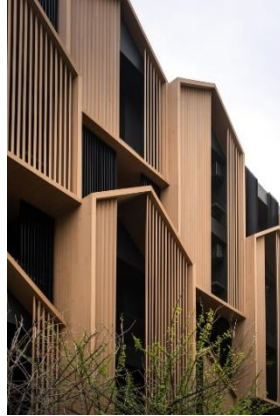
Gambar V.31 Garis-garis Kayu Pada Bukaan
