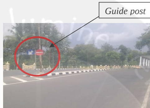
Gambar 2.11. Guide Post (Jembatan Bunder, Foto diambil tanggal 2 Mei 2010)
