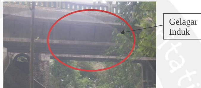
Gambar 2.1. Gelagar Induk (Jembatan Tambalan 2, Foto diambil Tanggal 10 Januari 2010)
