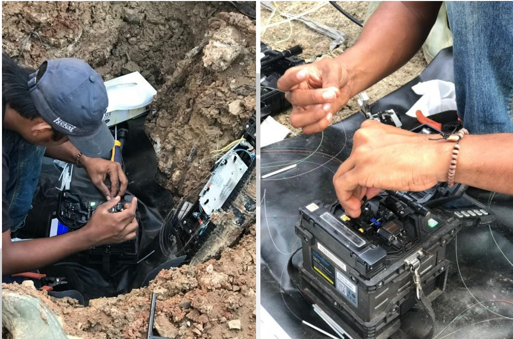
Gambar 4. Proses Penyambungan Kabel Fiber Optic
