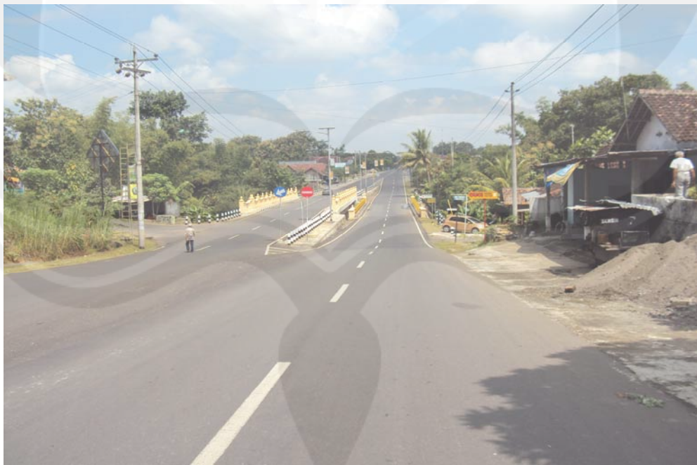
Gambar 1.3. Jembatan Jirak Tampak dari Selatan
