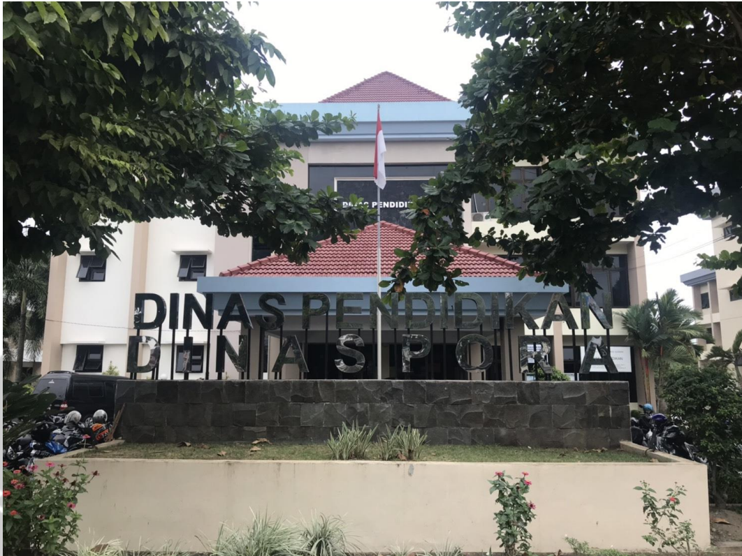
Gambar 2.22 Gedung dinas pendidikan tampak dari depan
