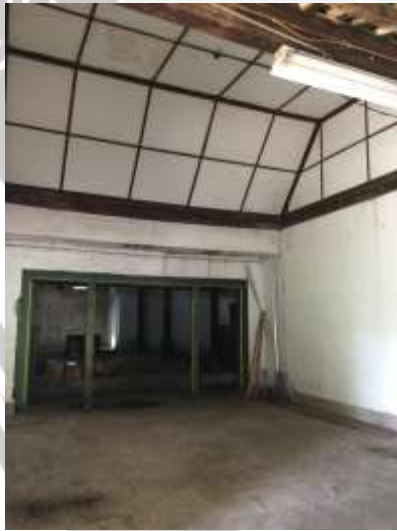
Gambar 135 Plafon Ekspose Pringgitan Ndalem Sumber: Dokumentasi Pribadi, 2018
