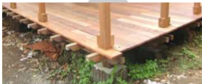
Gambar 127 Sistem Knock Down pada ruang Pameran Outdoor Temporary
