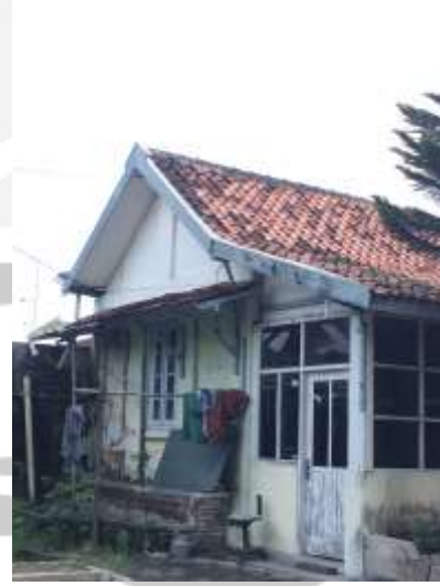
Gambar 136 Atap Limasan Gandhok Ndalem Sumber: Dokumentasi Pribadi, 2018
