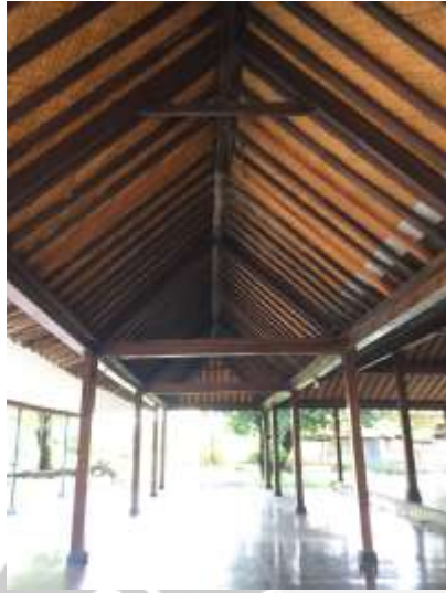
Gambar 133 Rangka Atap Ekspose Emper Pendopo Ndalem Sumber: Dokumentasi Pribadi, 2018
