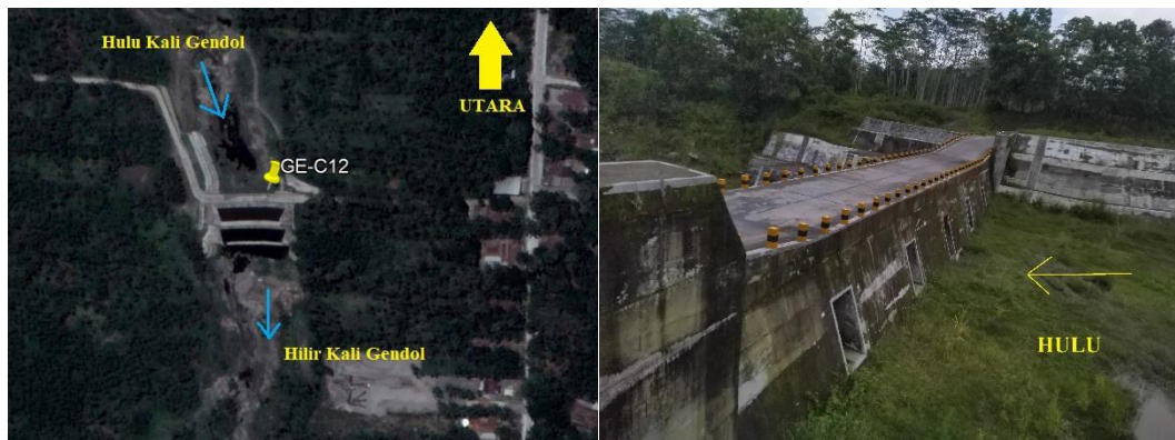
Gambar 1.2. (A) Lokasi Sabo Dam GE-C12 (Sumber: Google Earth) (B) Kondisi Eksisting Sabo Dam GE-C12 (Sumber: dokumentasi pribadi, diambil pada 24 Februari 2019)
