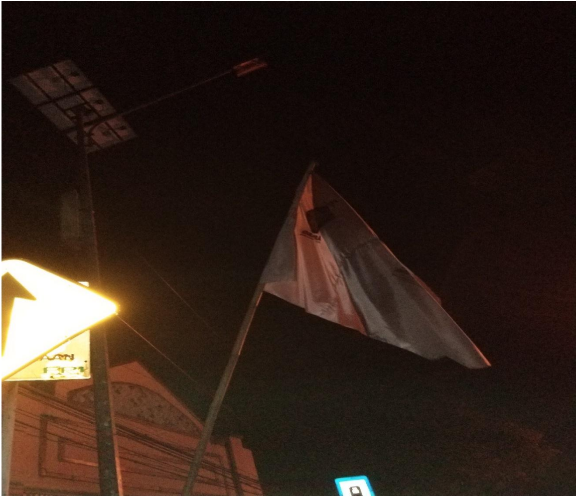
Lampiran 1.1. Kondisi lampu penerangan jalan yang telah rusak
