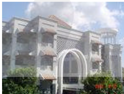
Gambar 6.6. Fasad Dekoratif Pada Bangunan UMY
