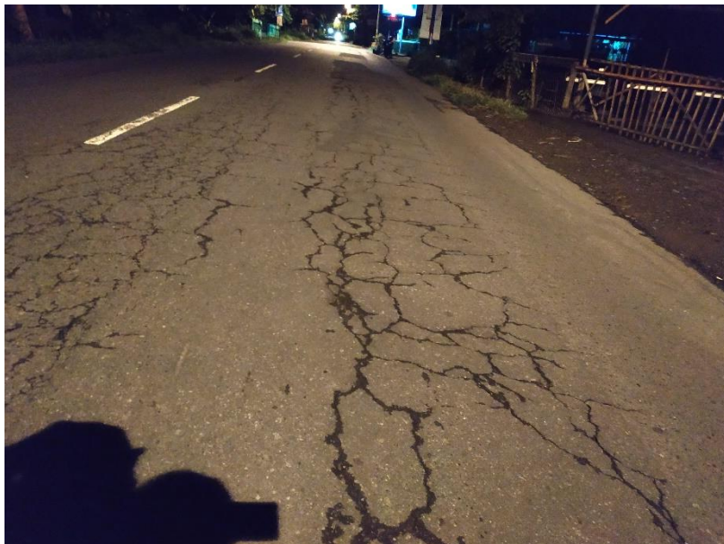
Gambar L2.2. Kondisi di Lokasi Pengambilan Data
