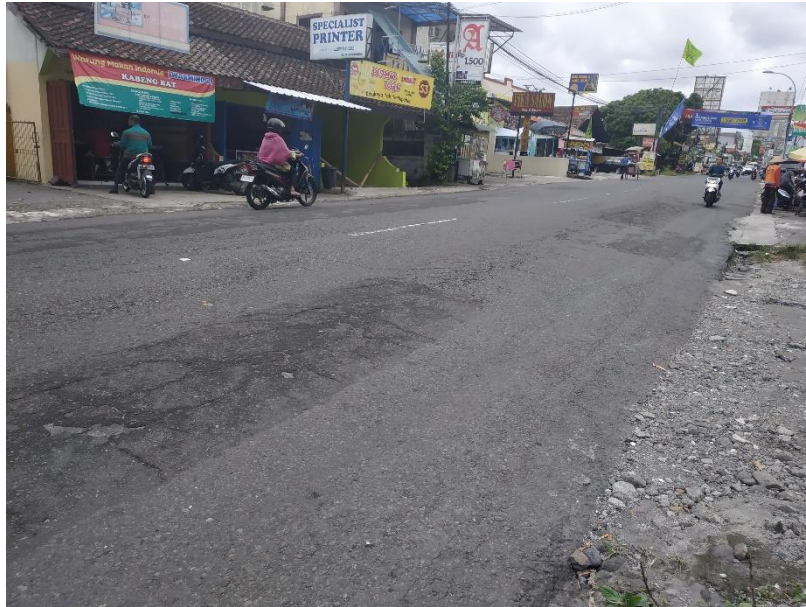
Gambar L2.1. Kondisi di Lokasi Pengambilan Data
