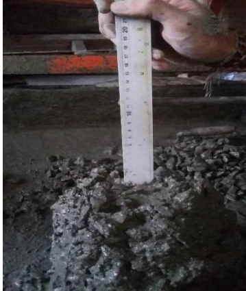
Pengujian Nilai Slump
