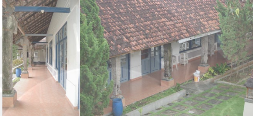
Gambar 1.2. Bangunan kelas SMP
