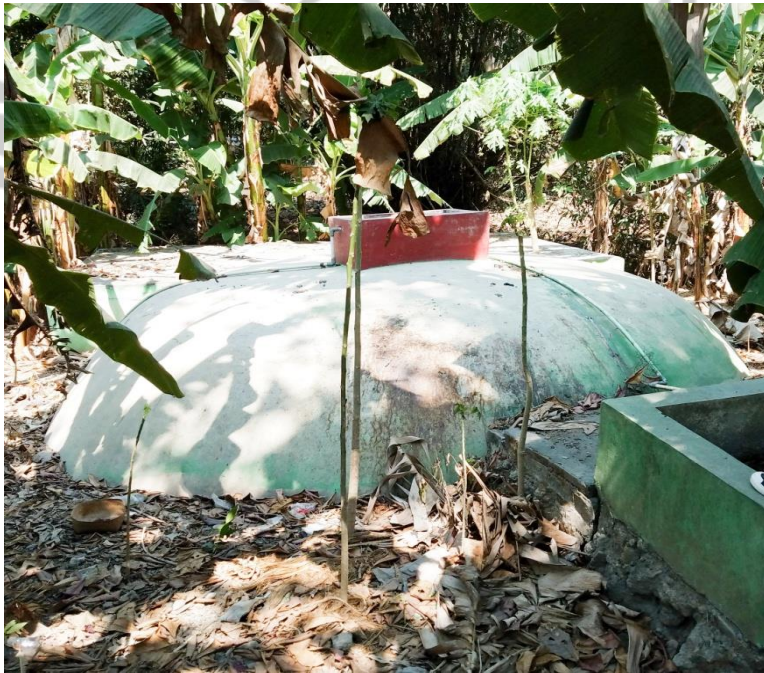
Gambar 10. Tempat Pengolahan Limbah ( Biodigester )
