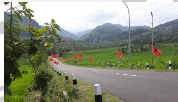
Gambar 6.4 Foto Jalan Raya Kaligesing dari Site
