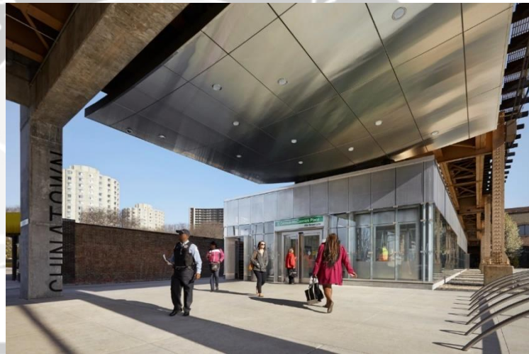
Gambar 2. 19 Perpaduan Material Beton, Kaca, Dan Polikarbonat Sumber: www.archdaily.com
