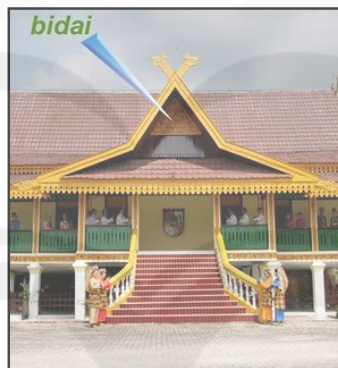
Gambar 6.11 : Contoh Penempata Bidai Pada Bangunan (Sumber : Dokumentasi Pribadi)
