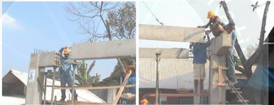
Gambar 2. 13. Konfigurasi penyambungan pra cetak Kolom-Balok Sumber : http://wiryanto.blogdetik.com/2007/06/16/precast
