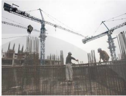
Gambar 2. 12. Penggunaan Tower Crane dalam pembangunan gedung bertingkat tinggi Sumber : properti.kompas.com
