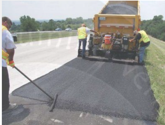
Gambar 2. 10. Proses pelapisan aspal Sumber : bitumen-asphalt.blogspot.com
