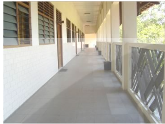
Gambar 2.8. Koridor Ruang Kelas Sumber : koleksi pribadi
