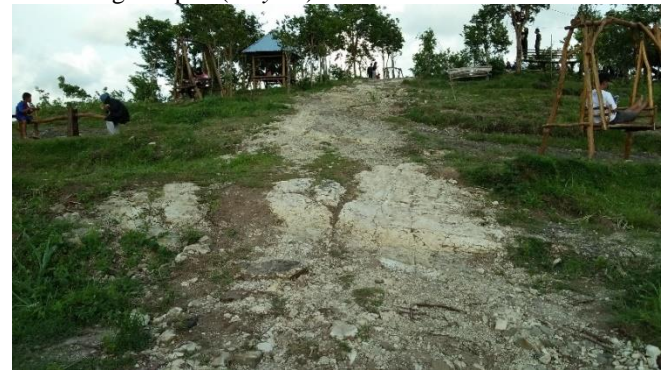
Gambar 9. Kondisi eksisting jalan . Sumber: Survey (2018)
