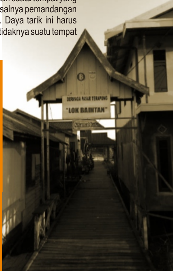
Gambar 3. Kondisi Eksisting Dermaga Pasar Terapung Luk Baintan (Sumber: Survey, 2017)
